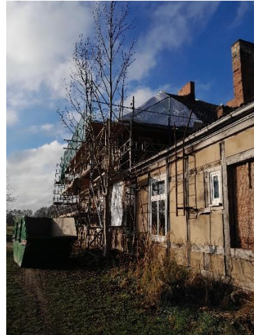
Fortschritt auf dem „Plänitzbau“
